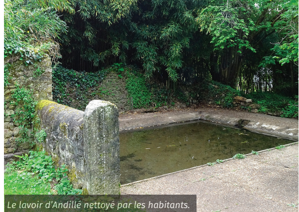
Le lavoir d'Andillé nettoyé par les habitants.
